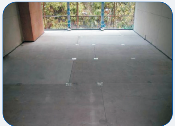
干式安装 (安装混凝土板后)
